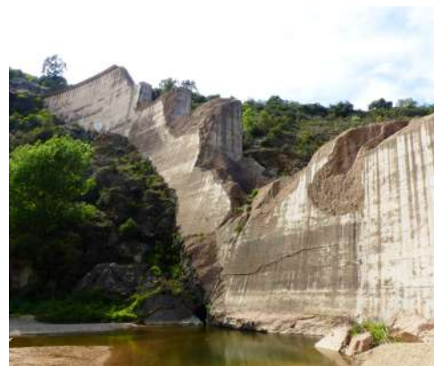
Barrage de Malpasset - 1959
